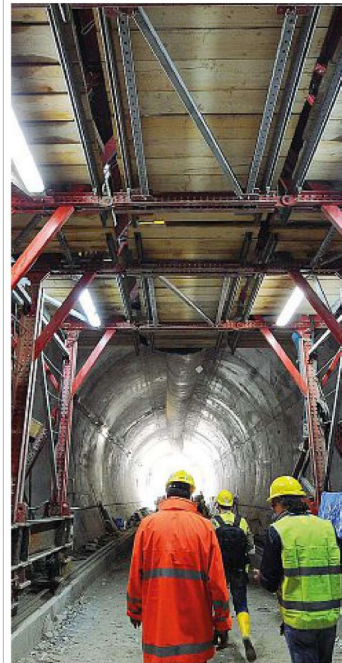
Operai al lavoro nel cantiere di una galleria
