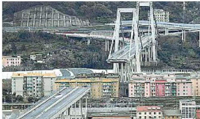
Disastro Il viadotto sul Polcevera gestito da Aspi crollato il 14 agosto 2018
