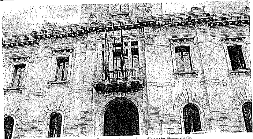
Rischio crac Palazzo San Giorgio "oscilla" tra salvataggio e dissesto finanziario
