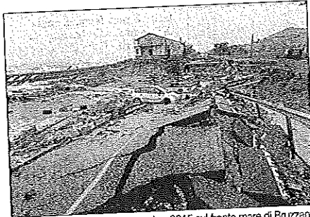
I disastri dell'alluvione del novembre 2015 sul fronte mare di Bruzzano
