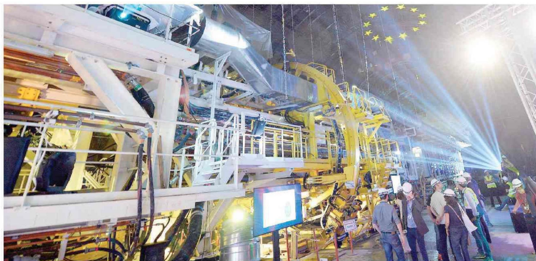
La presentazione dello scavo del versante Francese a Saint- Martin-La-Porte del tunnel Ferroviario Lyon-Torino (immagine d'archivio)
