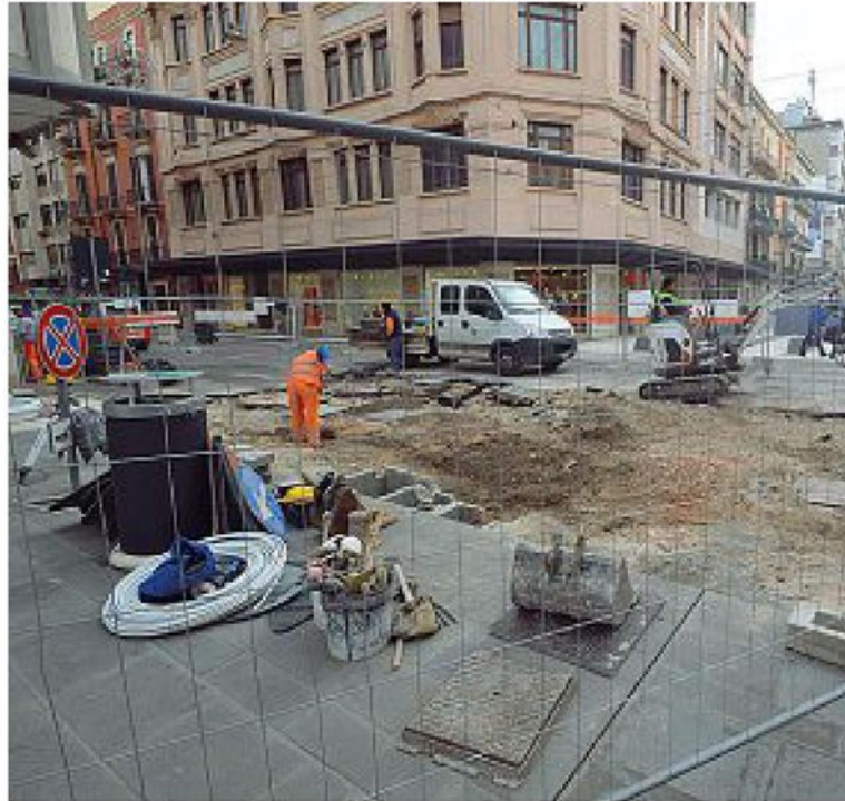
In città Un cantiere aperto nel centro cittadino di Bari
