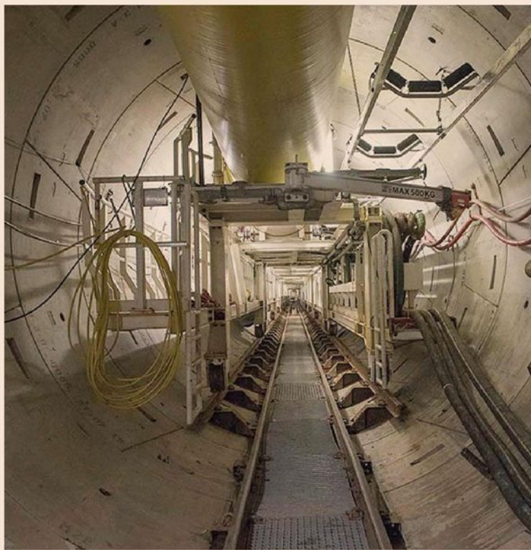
Salini Impregilo. Il tunnel idraulico di 12 Km in costruzione a Buenos Aires
