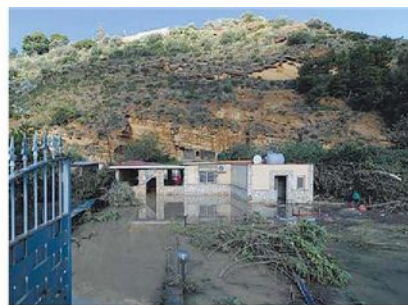
La villa di Casteldaccia (Pa) alluvionata (LaP)
