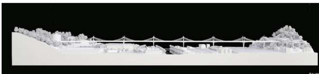
Il modellino virtuale di uno dei nuovi viadotti per la A10 disegnati dagli studi di Calatrava per Cimolai: interamente in metallo e "strallato" (un'altra simulazione è in prima pagina)
