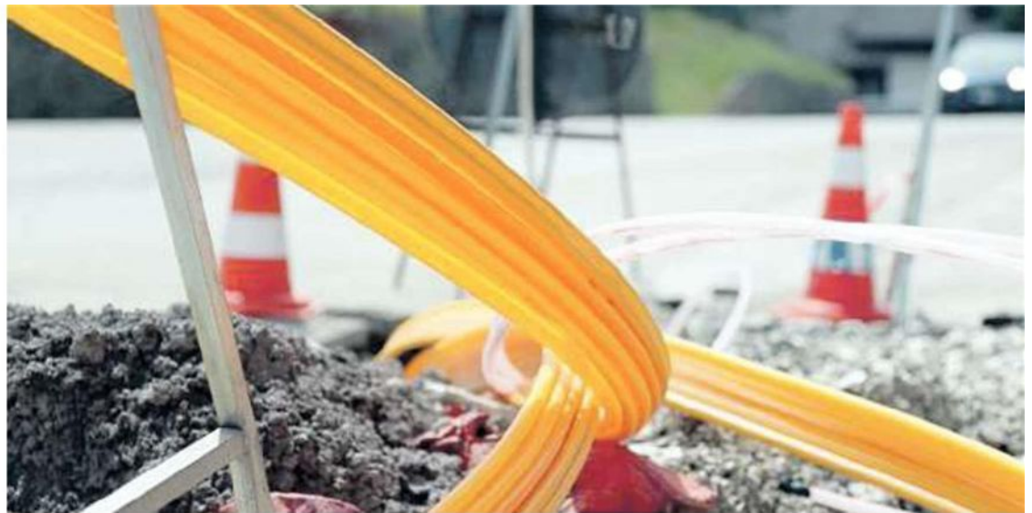
Lavori per installare la rete in fibra ottica
