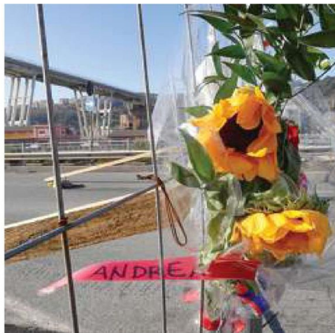
Fiori dei parenti delle 43 vittime del crollo, ormai oltre tre mesi fa
