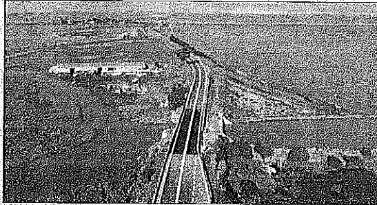
Il ponte ripristinato da Ansa nel Cagliariano in tempi record. A destra il Ponte Allaro
