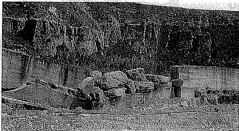
Milioni fanno del servizio idrico. Gli argini rotti della fiumara collegata al sistema idrico del Tuco dopo l'alluvione dell'inizio del 2017. Sotto uno dei tubi che erano nei cunicoli del Calopinace (ormai corrosi e pieni di fango) e il passaggio della più recente condotta nel tratto che attraversa il nuovo Palazzo di Giustizia.
