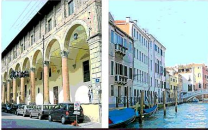
BOLOGNA VENEZIA L'ex Ospedale dei Bastardini a Bologna e le Fondamenta di S. Lorenzo (l'edificio più alto) a Venezia
