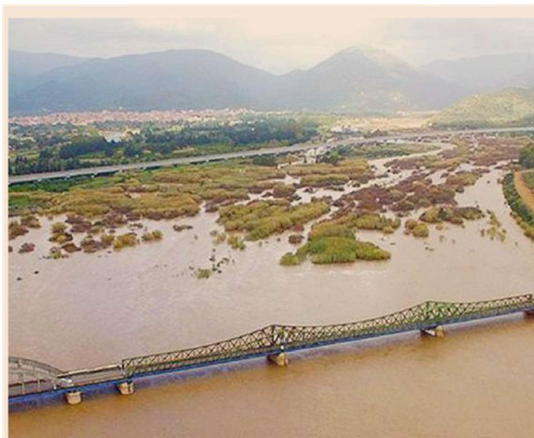
Sotto osservazione in Sardegna Il ponte sul Flumendosa, situato a Villaputzu
