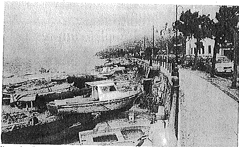
L'operazione il progetto prevede l'allargamento del Lungomare di Cannitello
