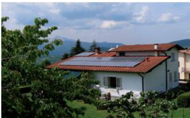
impianto a servizio di abitazione
