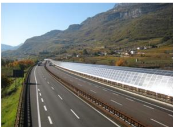
impianto su autostrada (barriera acustica)
