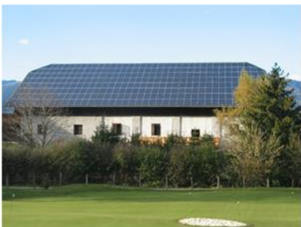
impianto su capannone
