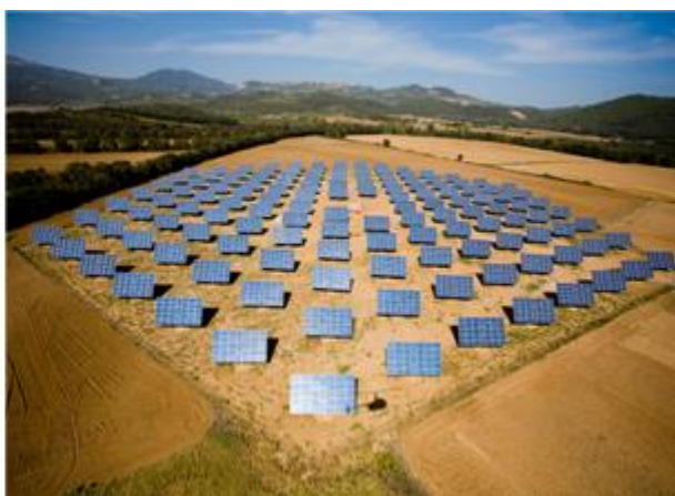
impianto a terra
