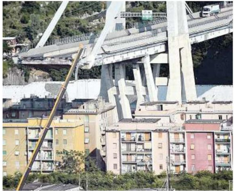
Il moncone del ponte crollato il 14 agosto che sovrasta le case
