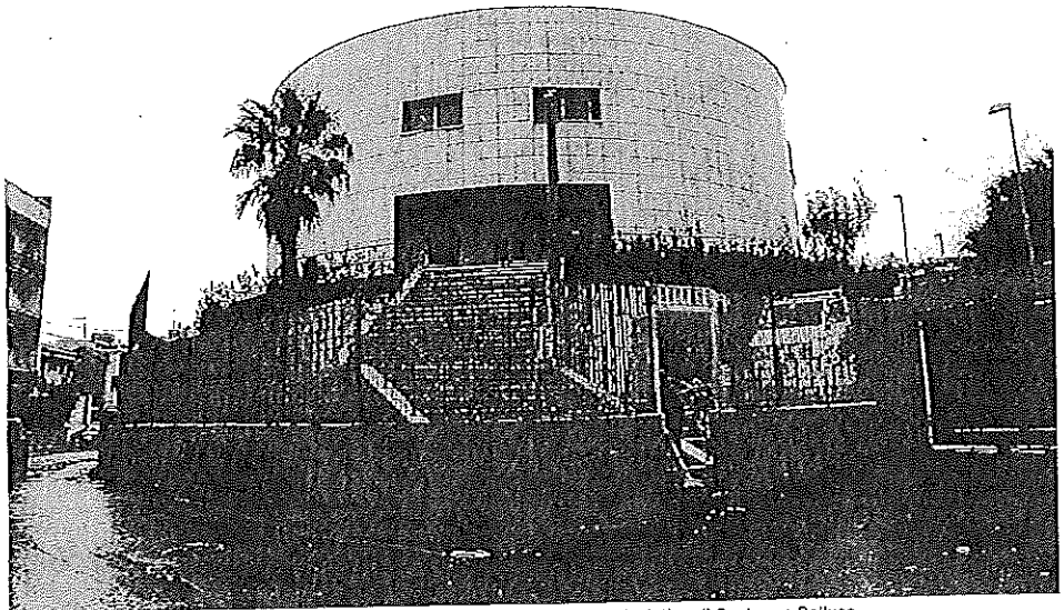
La sede. La struttura del centro di gestione del sistema idrico ospita la base logistica di Castore e Polluce
