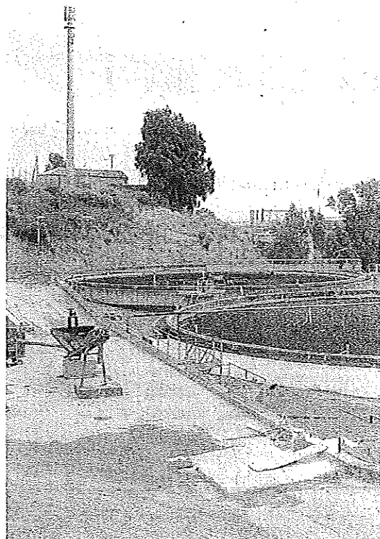
Le vasche del depuratore di Catanzaro Lido
