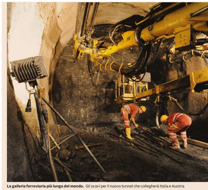
La galleria ferroviaria più lunga del mondo. Gli scavi per il nuovo tunnel che collegherà Italia e Austria
