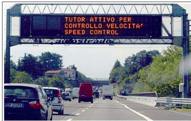
I tutor attivi sulle autostrade italiane sono oltre trecento
