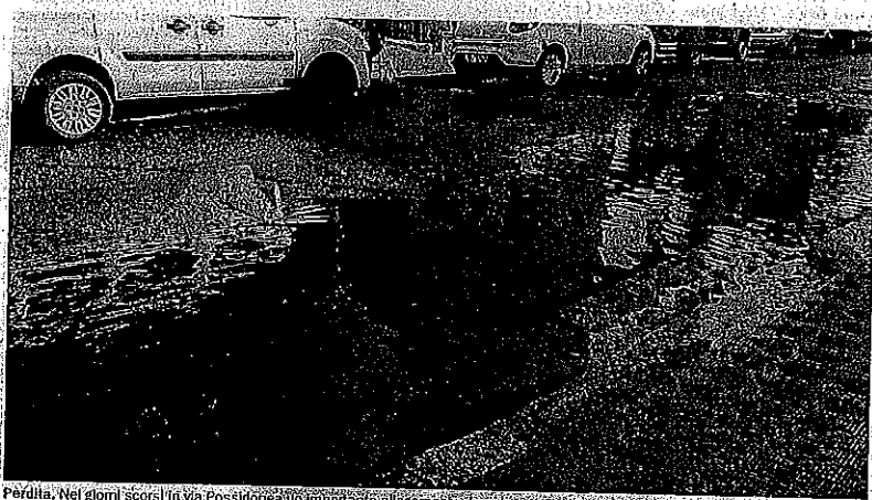
Perdita. Nei giorni scorsi in via Possidonea un importante allagamento dopo la rottura di una condotta, poi l'intervento del Comune
