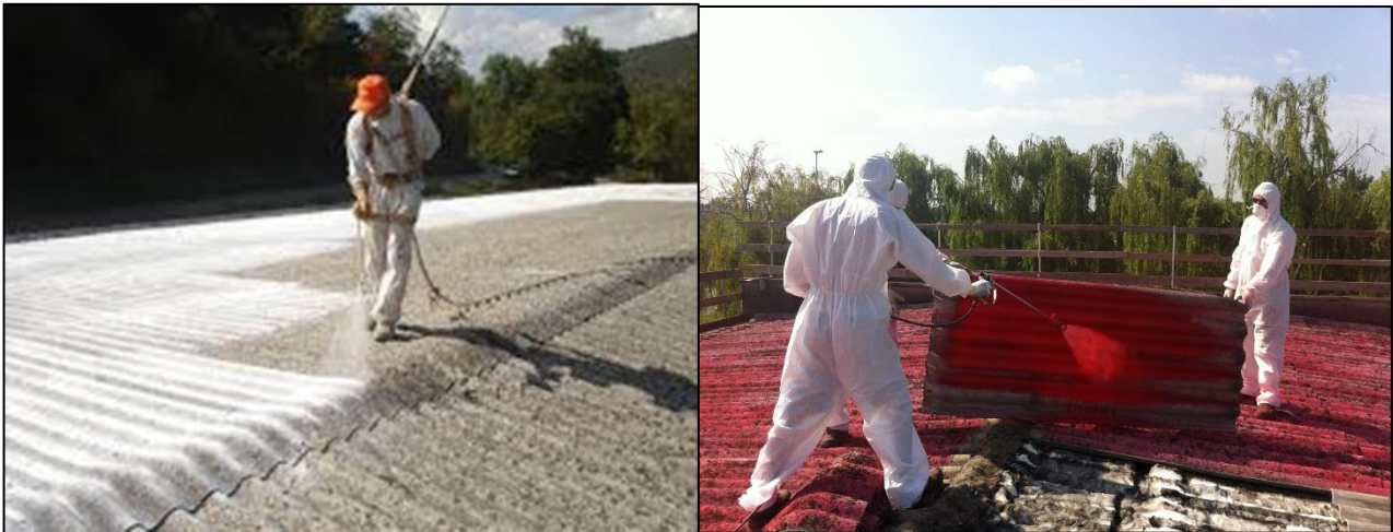
Figura 1 incapsulamento e rimozione di pannelli di cemento amianto
