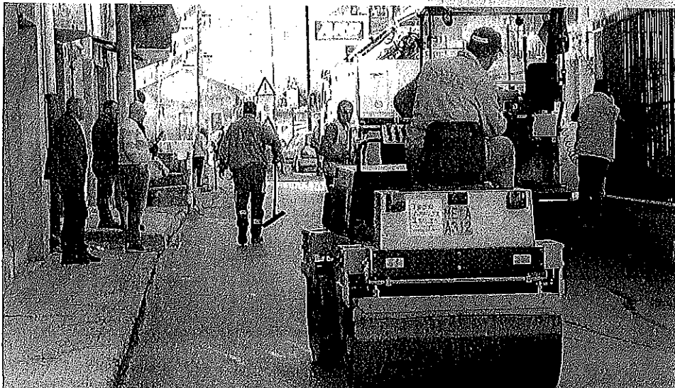
Non è solo questione di estetica. L'intervento per la bitumazione delle strade strategico per rendere la circolazione più sicura
