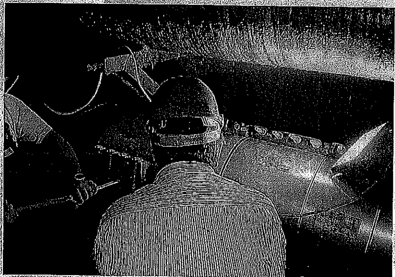
Condotta calabrona. I tecnici al lavoro per ripristinare l'erogazione dell'acqua nella condotta del Calopliace, ora per fortuna va meglio.
