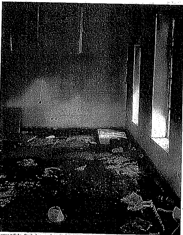
Danneggiata. Così si presentava l'interno dell'ex emeroteca dopo il primo incendio scoppiato a settembre scorso; il nuovo rogo di domenica ha ulteriormente inferto un colpo alle stabi-
