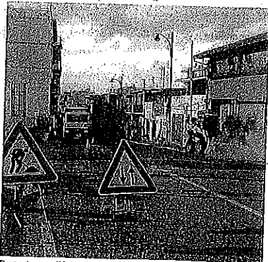
Proseguono gli interventi. I nuovi segnali in via Sbarre Centrali
