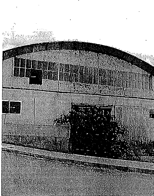
Abbandonato. L'immobile denominato ex Italcitrus a Catona. Questo è solo uno dei tanti siti dove è presente l'amianto che è bandito per legge e deve essere completamente rimosso
