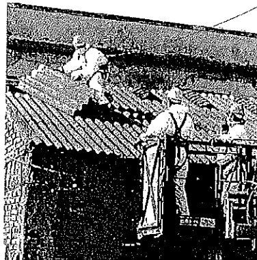
Noctiva. Alcune operazioni di bonifica dell'amianto presente sulle case
