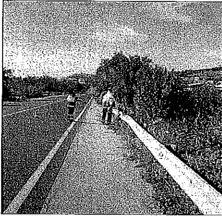
I lavori di pulizia sulla SS 106
