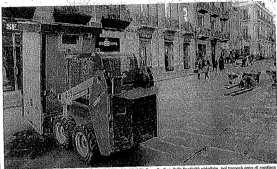
Torna libero. Il Corso Garibaldi da oggi sarà interamente transabile fino alla fine delle festività natalizie, poi tornerà area di cantiere
