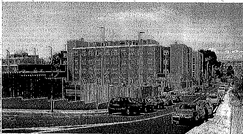
Sublocata. La procedura per la realizzazione del nuovo ospedale ha registrato un'importante svolta in avanti
