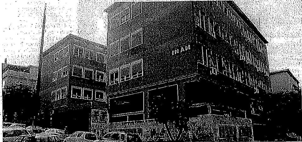
La ristrutturazione. L'intervento di riqualificazione è previsto da un decennio ma per eseguirlo si dovrebbe sgomberare l'immobile
