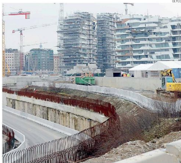
Cantiere aperto La rinascita della Vecchia Fiera di Milano, oggi Citylife
