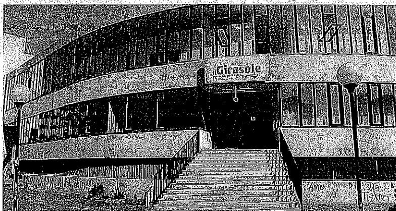
La scelta. La struttura del Girasole del viale Messina, diventerà la base logistica della nuova società comunale Hermes.
