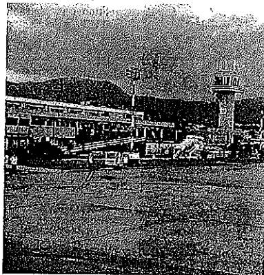
Scenari incerti. Una veduta dello scalo aeroportuale da luglio gesito dalla Sacal dopo il fallimento della Sogas
