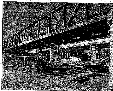
Lavori al rilento sul ponte Allaro
