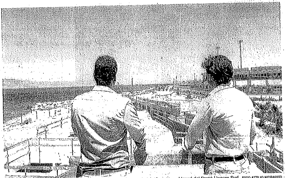
Sguardo al futuro. Il vice Armando Neri con il sindaco Giuseppe Falcomatà seguono i lavori del Parco Lineare Sud. FOTO ATILIO MORABITO
