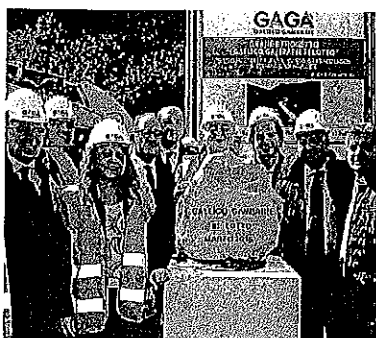
La prima pietra. Nel marzo 2016 sono stati avviati i lavori
